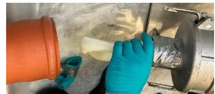
3. Kalibrierschlauch über den umgestülpten **BRAWOLINER<sup>®</sup>** auf dem Inversionstutzen ziehen und mit Schlauchschellen befestigen.
