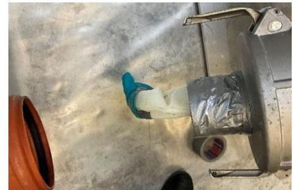
2. Zum Umstülpen und Befestigen des **BRAWOLINER<sup>®</sup>** Anfang Linerverschluss entfernen und den Liner über den Inversionstutzen ziehen.
